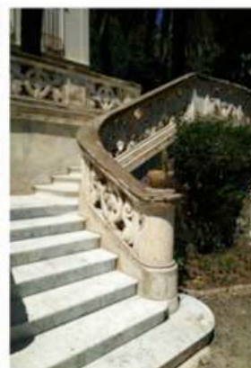
RESTAURATION DU BÂTI ANCIEN
