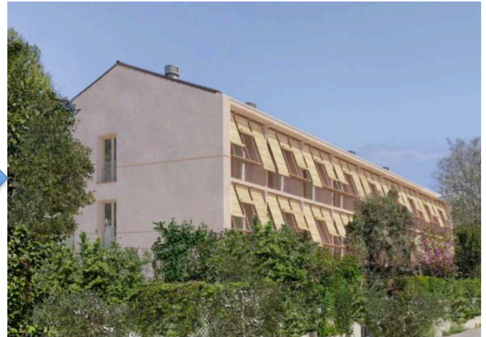
Ave de l'auberge depuis la rue avec les allèges en briques vitrées.
