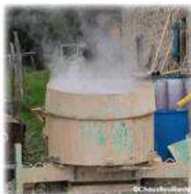
Chantier restauration maison - Béme s., St Pardoux, 2024
